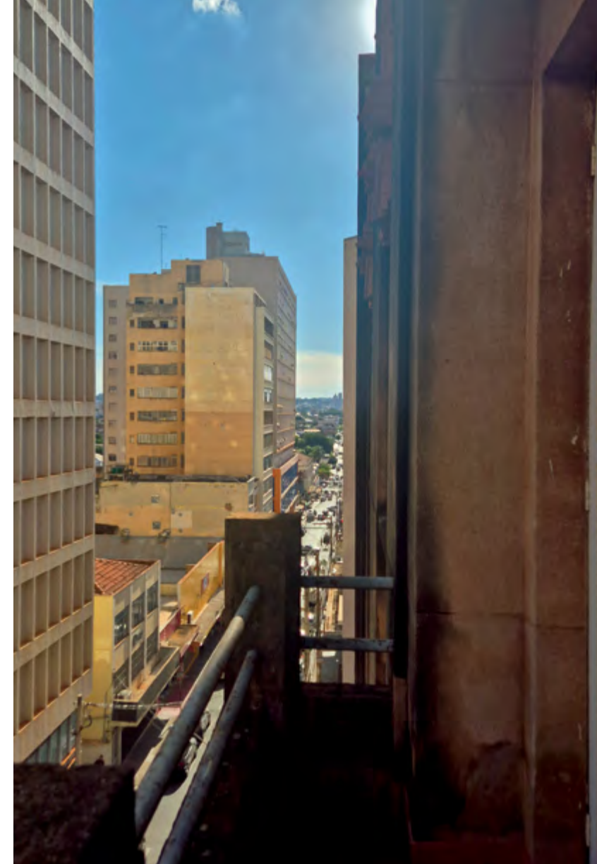
Vista externa na sacada da fachada do edifício
