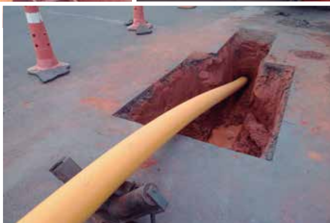
Rede Secundária - Projetos São Simão e Bebedouro
