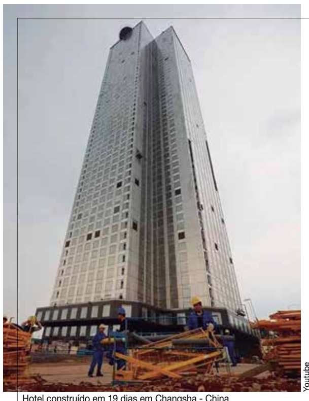
Hotel construído em 19 dias em Changsha - China
