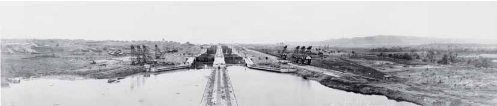
A construção das eclusas, em 1913
