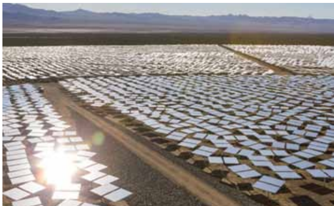
Ivanpah é formada por 300 mil espelhos com 2 metros de altura e 3 metros de largura cada
