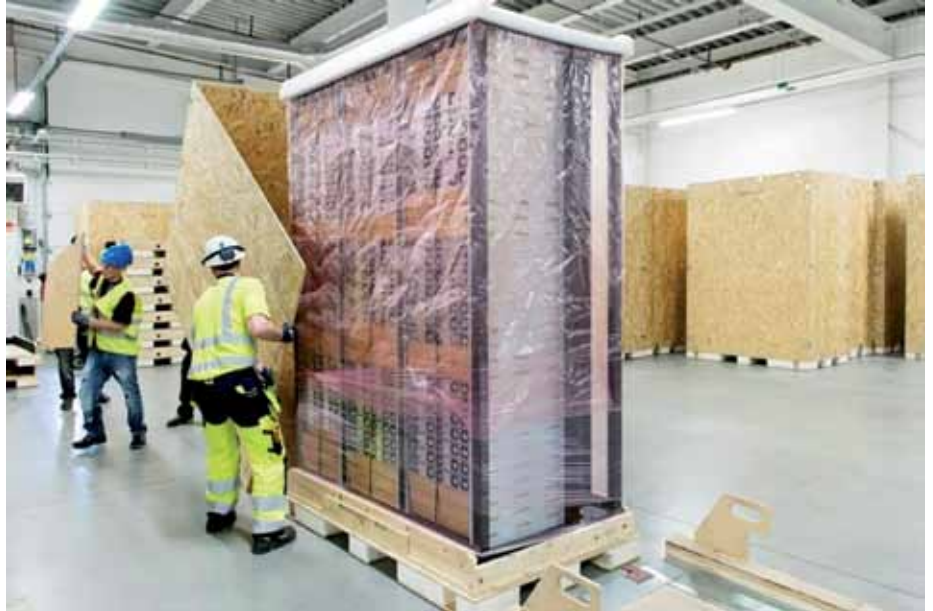
Os conceitos básicos de design usados nas construções dos data centers são comparados a montagem de um carro em um chassi
