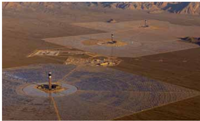
Os espelhos são controlados por computadores e refletem a luz do sol em torres de 140 metros de altura
