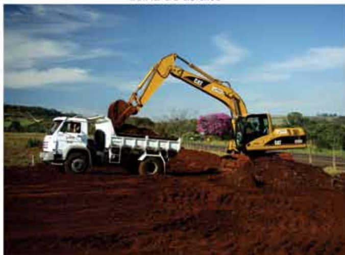
serviços de terraplenagem
