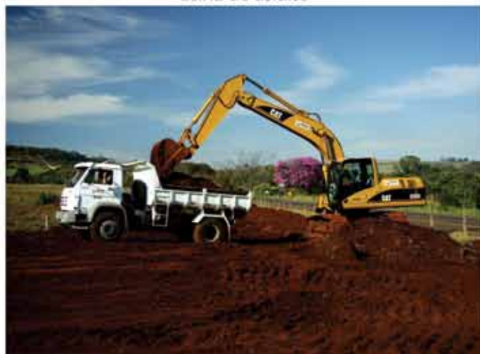
serviços de terraplenagem
