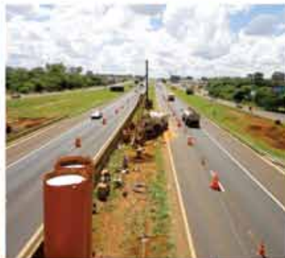
Viaduto Av. Henry Nestlé
