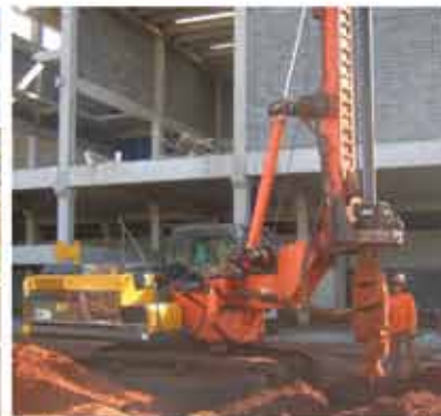
Ampliações Novo Shopping
