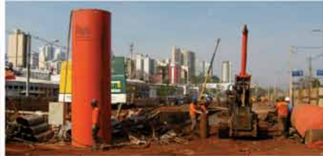
Canalização Córrego Ribeirão Preto
