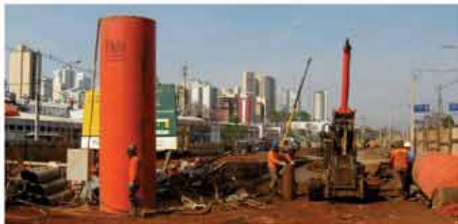
Canalização Córrego Ribeirão Preto
