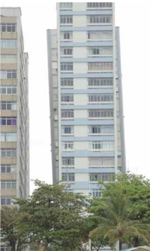
O edifício Núncio Malzoni
