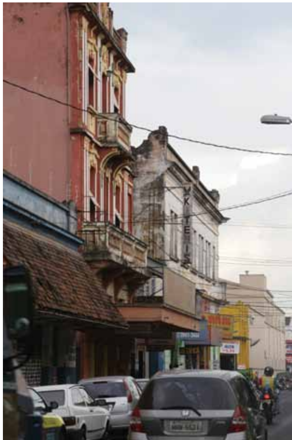
Levantamento mostra a face arquitetônica da Rua José Bonifácio
