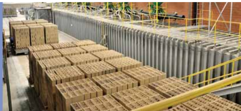
Vista geral do novo forno inaugurado em novembro de 2010 Fábrica Cesário Lange - SP
