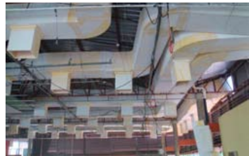
Fotos: Instalação da climatização no salão de festas
