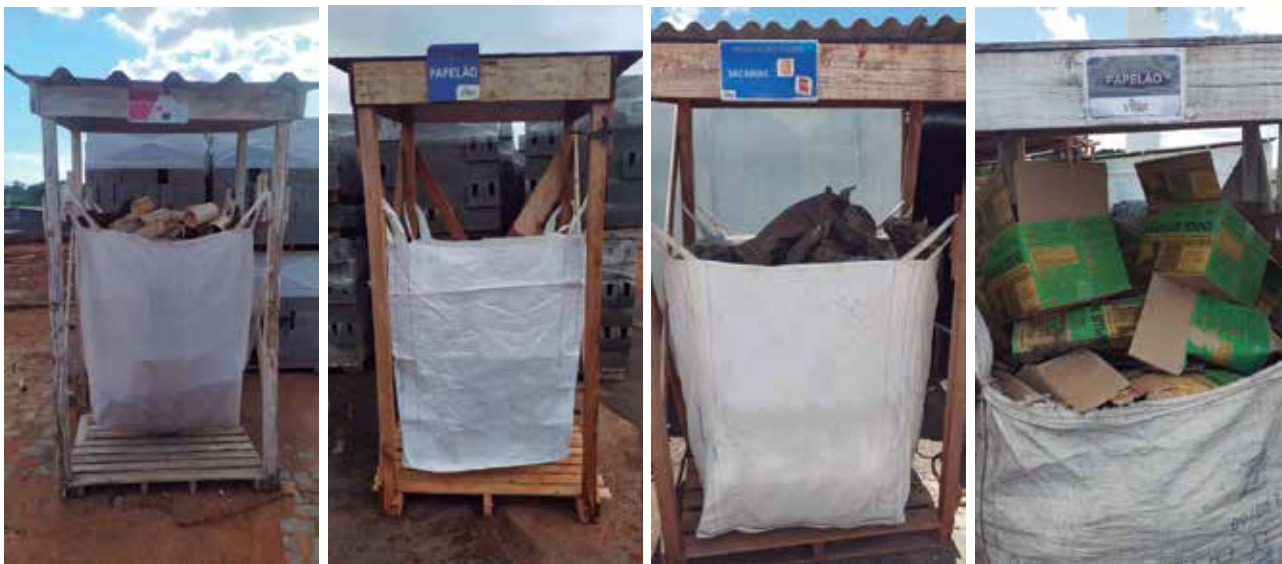
Armazenamento de plásticos duros, papelão e sacarias em canteiros.
